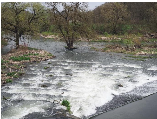
Die Fischtreppe am Donauwehr
