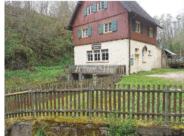
Das Kraftwerk des Klosters Untermarkthal
