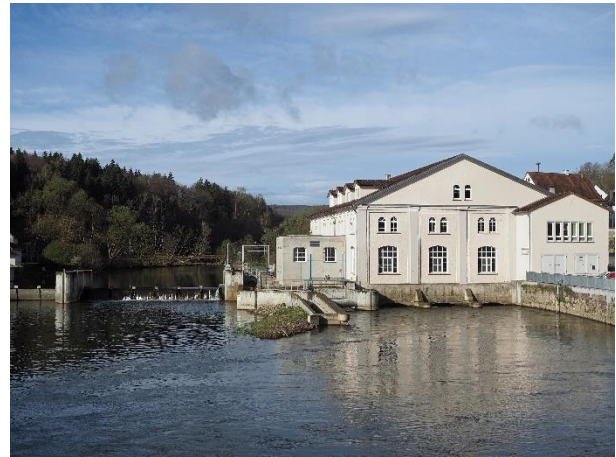
Das Wasserkraftwerk Rechtenstein
